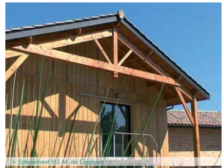
Lotissement H.L.M. de Captieux
